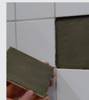
Tätningsmassan påförs underlaget och plattan monteras
