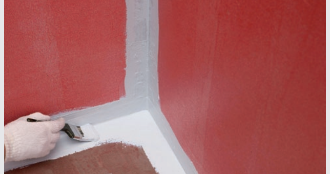
Montering av Armeringsremsa i tätningsmassa
