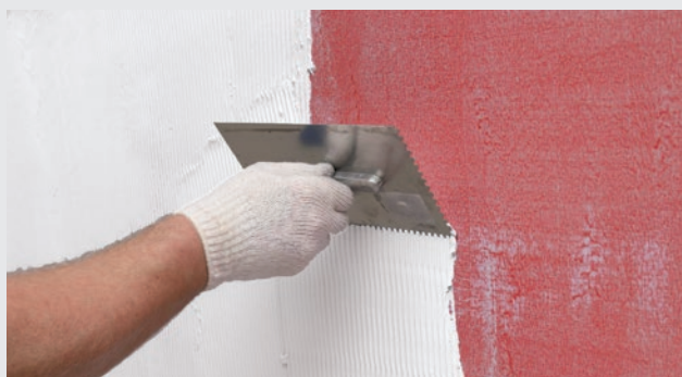
Påföring med tandspackel...
