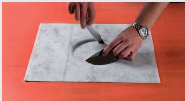
Skär ut hålet med kniv eller specialverktyg
