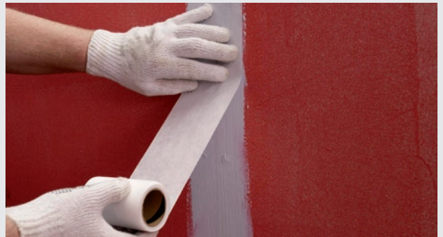
Skivskarvar förseglas med Armeringsremsa monterad i tätningsmassa
