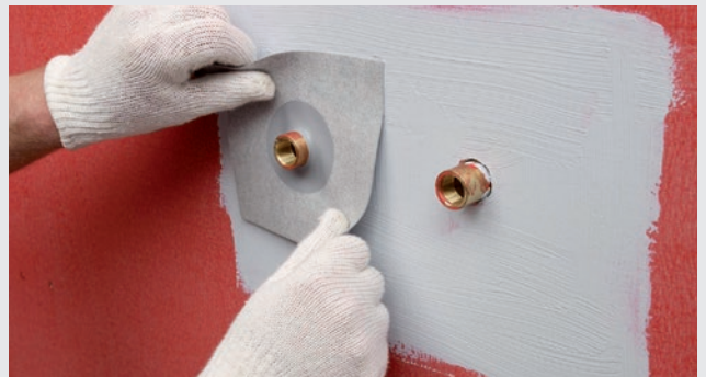
Montering kring rör med Rörmanschett i tätningsmassa
