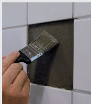
Tätningsmassan påförs underlaget och plattan monteras
