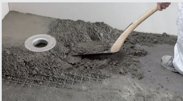
Golvlutning med cementbruk
