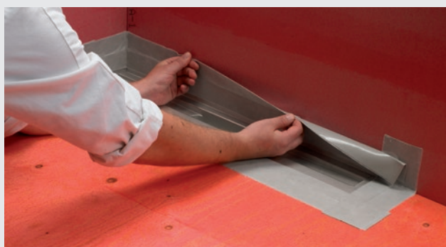
Montering av Seal-Strip vid väggnära golvbrunn
