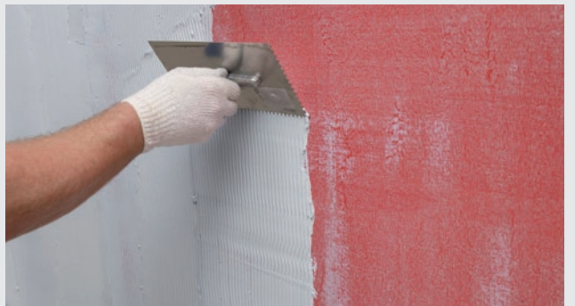
Påföring med tandspackel
