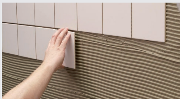
Montering av plattor på vägg
