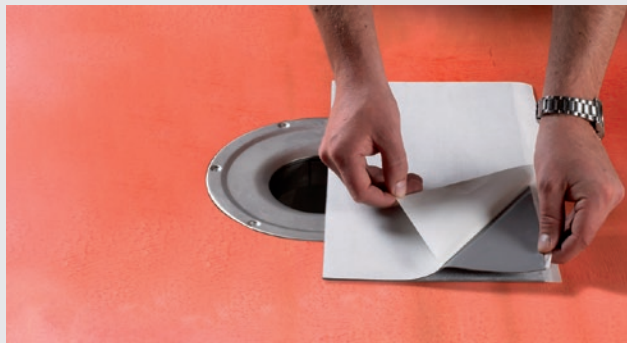
Montering av brunnsmanschett vid rund golvbrunn
