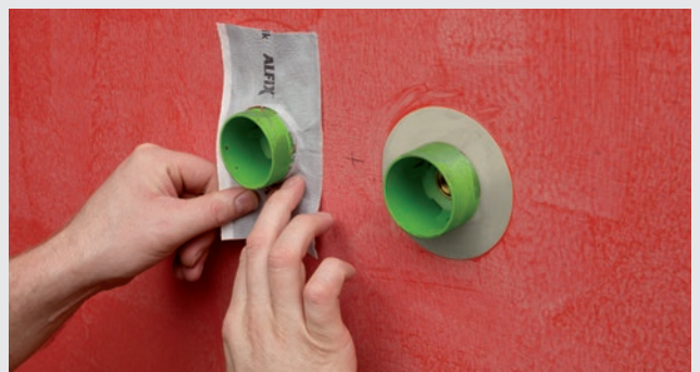
Montering kring rör med självhäftande Seal-Strip
