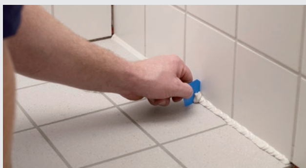
Överskjutande fogmassa skrapas bort
