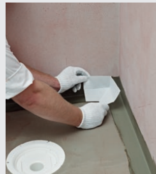
Reglering av sugförmåga Försegling i VT-hörn
