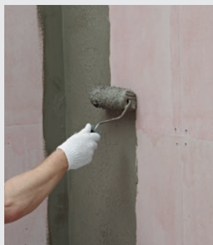
Påföring av tätningsmasse Montering av våd i hörn
