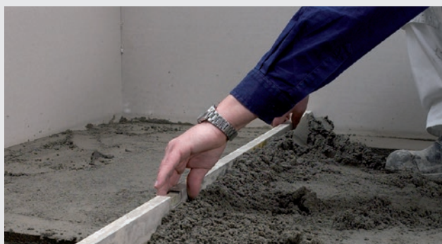
Gjutning på träbjälklag
