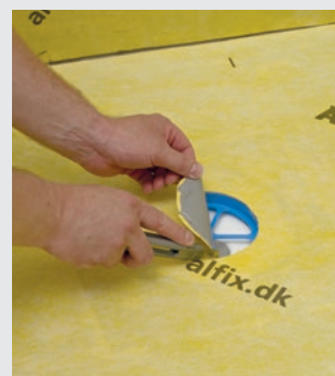
Utskäring med skärval vid manschett typ H
