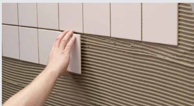
Montering av plattor på vägg
