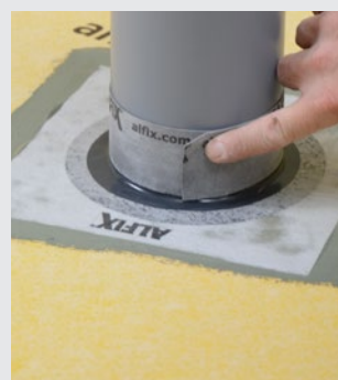
Förstärkning med Seal-Strip vid vattenbelastade rör
