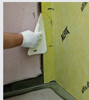
Påföring av tätningsmasse Montering av våd i hörn
