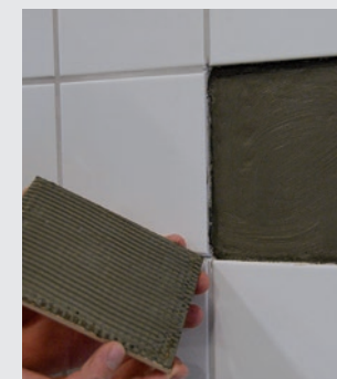
Tätningsmassan påförs underlaget och plattan monteras
