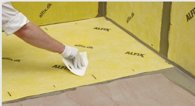
Montering av våd på golv
