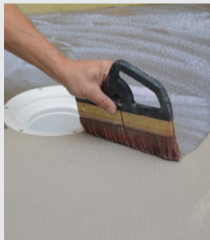
Reglering av sugförmåga Försegling i VT-hörn
