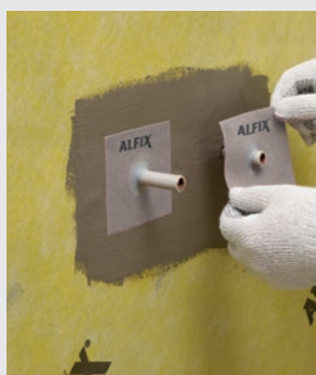
Montering av VT-Rörmanschetter
