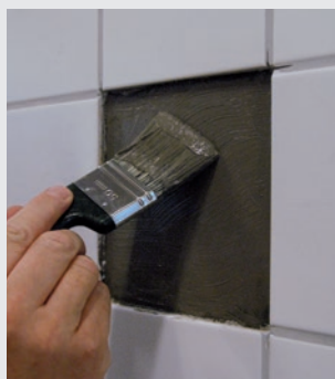
Tätningsmassan påförs underlaget och plattan monteras
