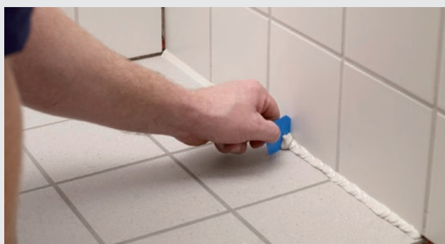
Överskjutande Alfix Silicon skrapas bort
