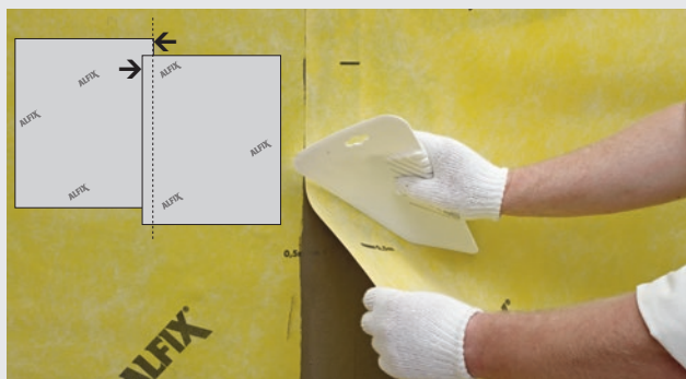
Montering av våd omlott vid skarv
