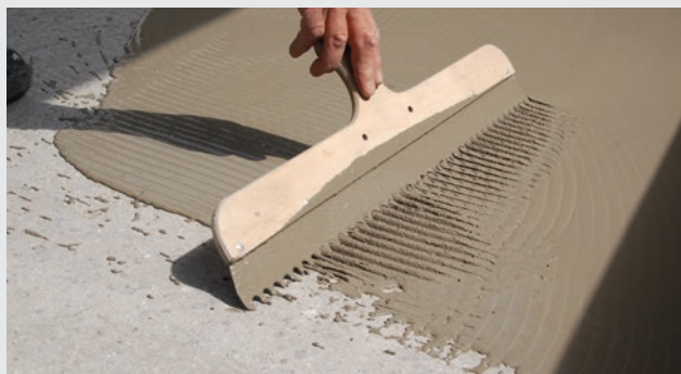
Fördelning med golvtandspackel
