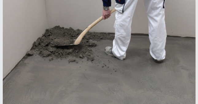
Cementbruk/slipsats fördelas jämnt
