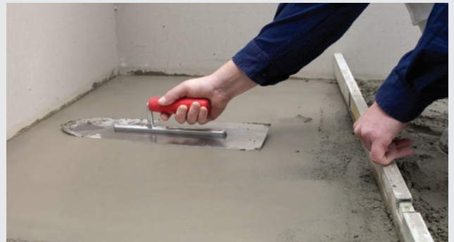
Cementbruk/slipsats glättas ut med spackel
