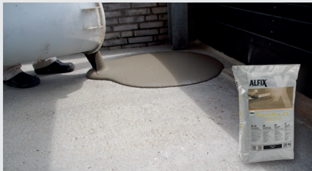
Självtjämnande spackelmassa hälls ut
