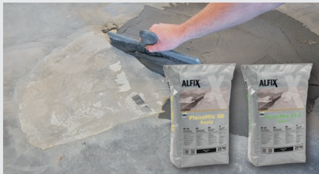
Sprickor och fördjupningar ifylls.
