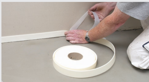
Montering av självhäftande väggkantband
