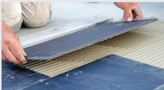
Montering av plattor
