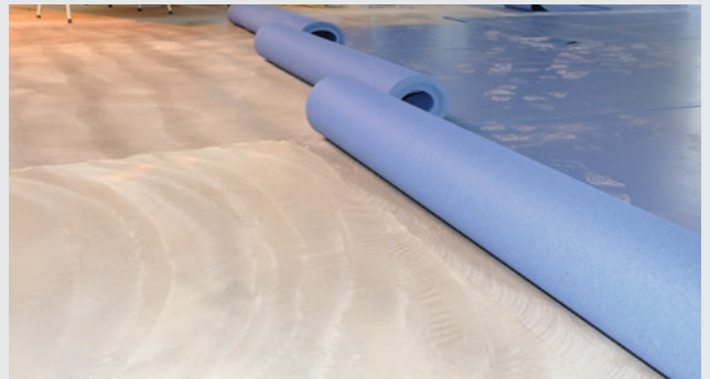
Montering av vinyl
