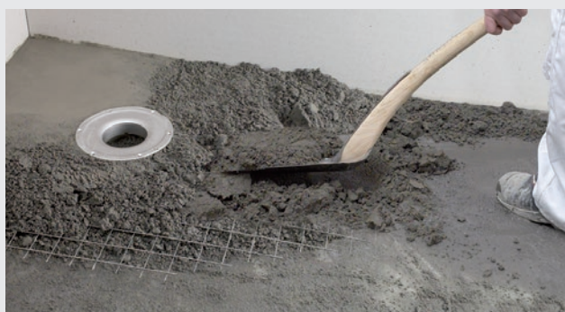
Uppbyggnad av fall med cementbruk/slipsats
