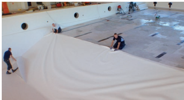
Montering av PVC-folie
