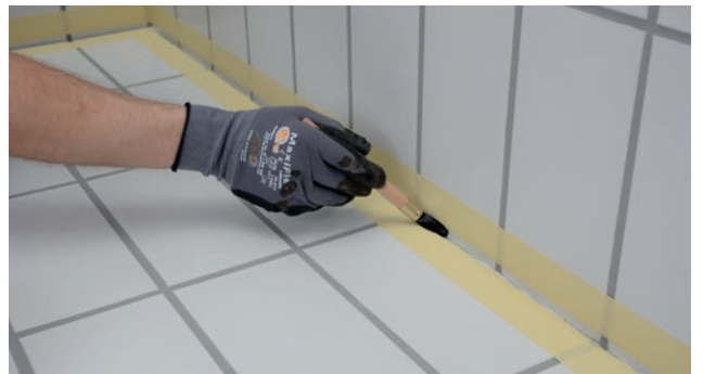
Efter fastklistring av maskeringstejp påförs primer
