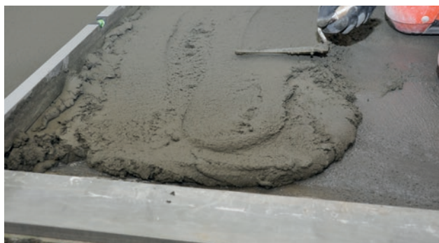
Utläggning och komprimering på golv
