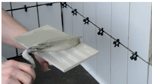
Dubbellimning (buttering/floating metoden)
