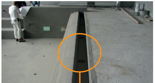
Montering av Alfix Tätningsband
