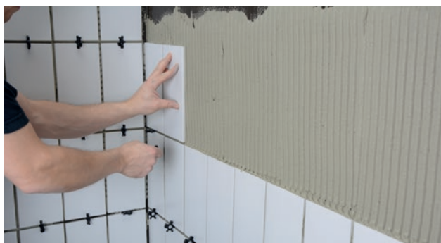
Montering av kakel
