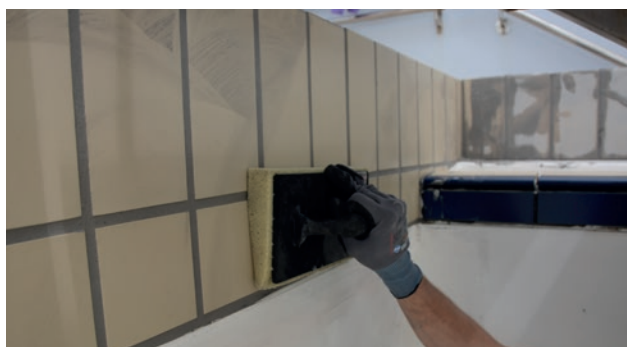
Kaklet jämnas och tvättas med en hårt urvriden viskossvamp
