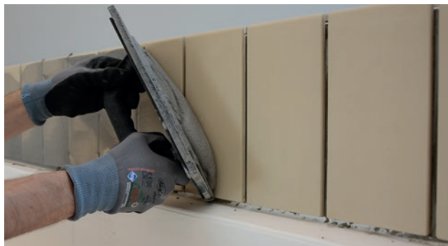
Ifylling av Alfix CeraFill 18 resistant
