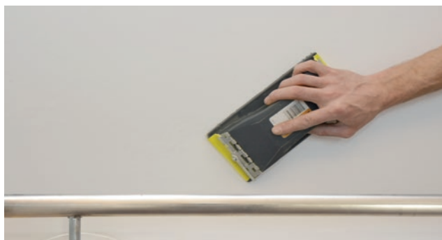
Grovslipning av PVC-folie
