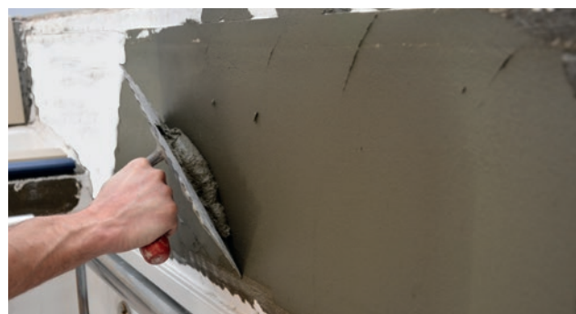
Applicering av kontaktskikt
