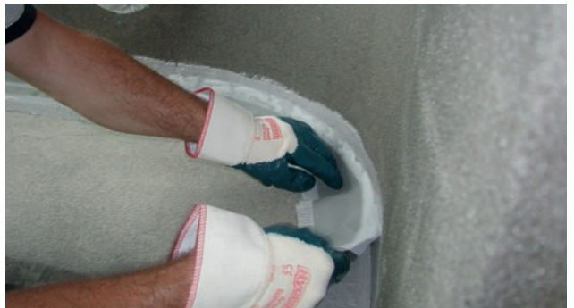
Montering av Alfix Tätningsband
