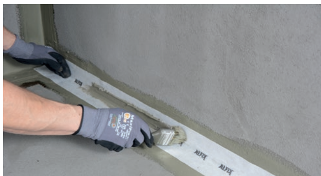
Montering av Alfix VT-tättningsband
