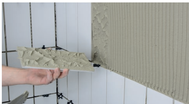
Kontroll av fästmassans täckning
