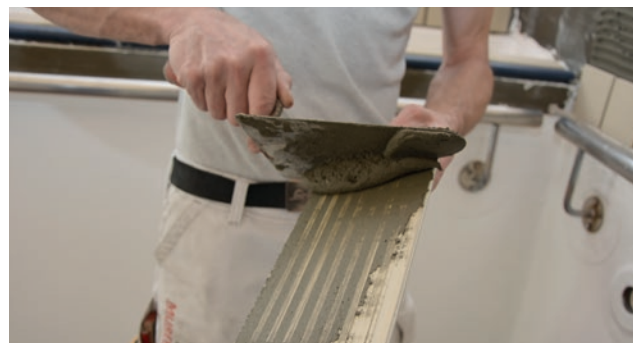
Applicering av kontaktskikt på kaklets baksida
