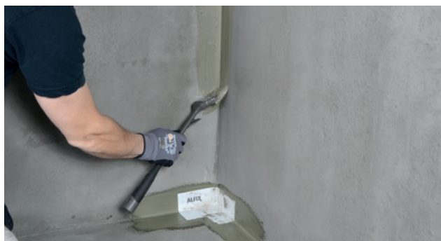
Montering av Alfix VT-hörn i tätningsmassa
