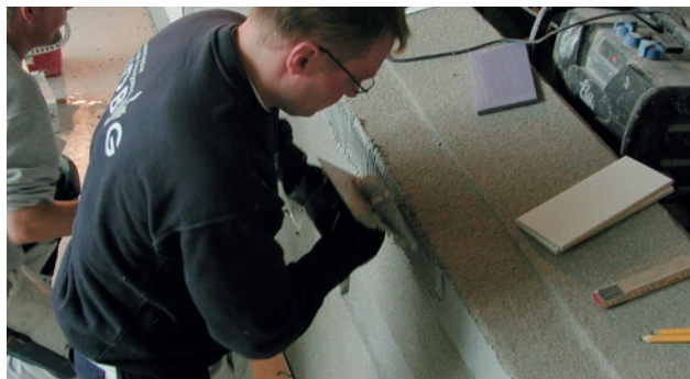
Applicering av Alfix C2 Epoxyfog med tandspackel
