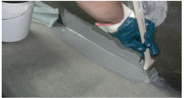
Applicering av Alfix Epoxy Membran
