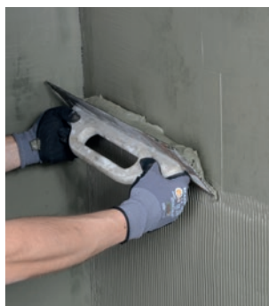
Applicering av 2K Tätningsmassa och glättning
