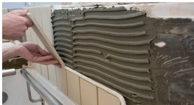
Montering av kakel
