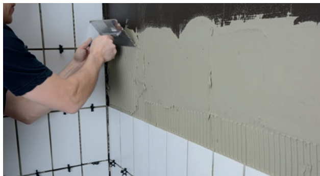
Applicering av fästmassa med tandspackel
