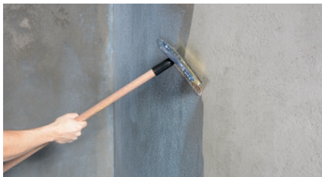
Primerbehandling med Alfix PlaneMixPrime
