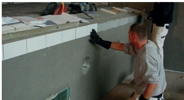
Montering av kakel i den fuktiga fästmassa
