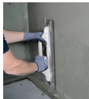
Applicering av 2K Tätningsmassa och glättning
