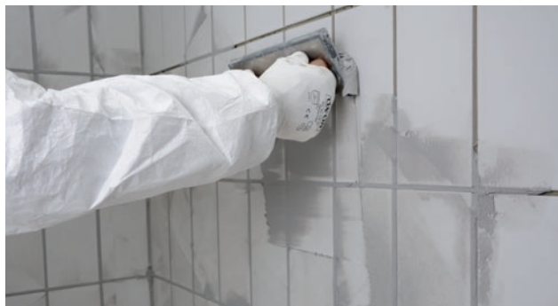
Ifyllning på vägg med epoxyfogbräda
