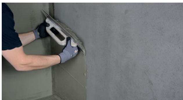
Applicering av Alfix 2K Tätningsmassa – porfyllande skikt
