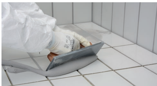
Ifyllning på golv med epoxyfogbräda
