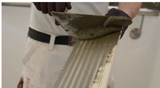
Applicering av kontaktskikt på kaklets baksida
