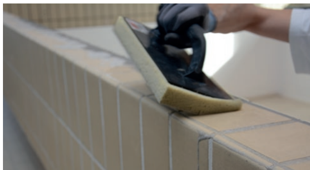
Fogarna anpassas efter kaklets utformning
