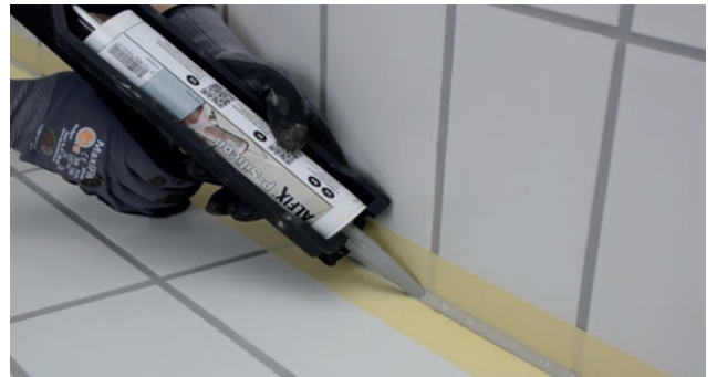
När primern är torr fylls fogarna med Alfix P-Silicon
