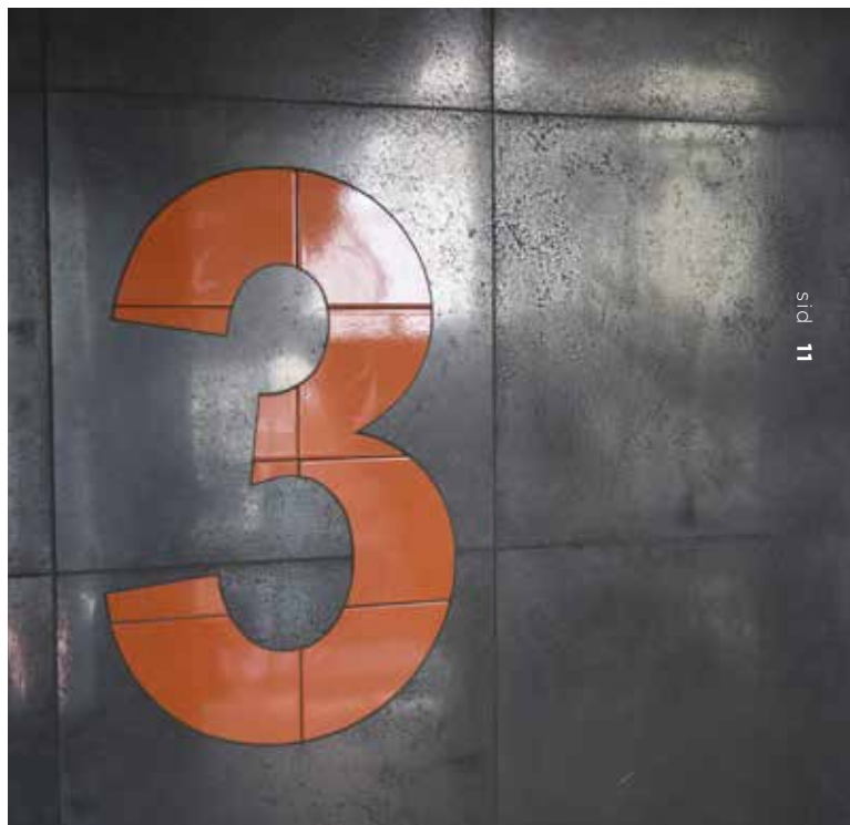
Keramikbeklädda väggar i parkeringshus. (Tengbom)
